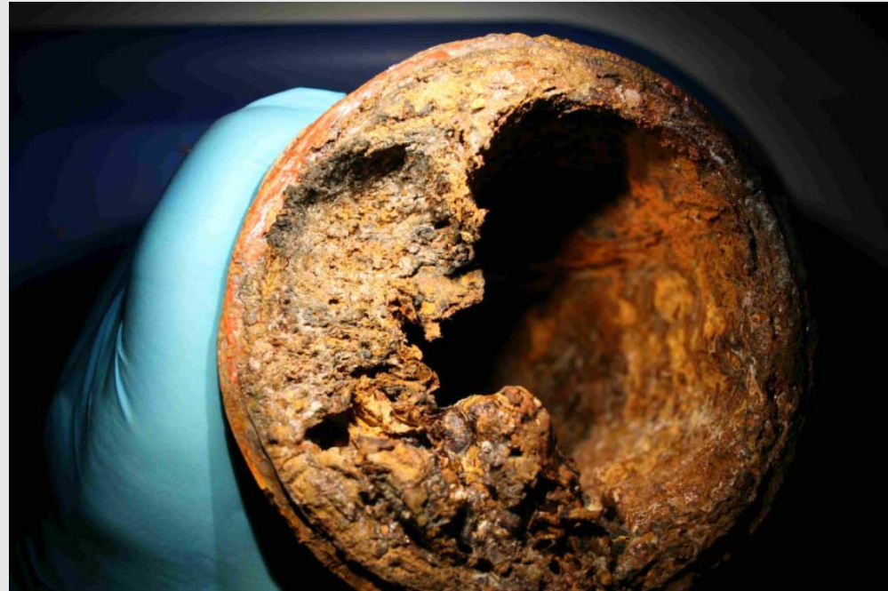
Korrosion eines Gussrohres (Eisensulfid- und carbonat)
